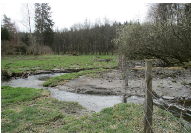
Foto gegen Fließrichtung
