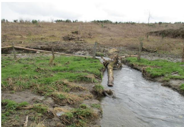
Foto gegen Fließrichtung
