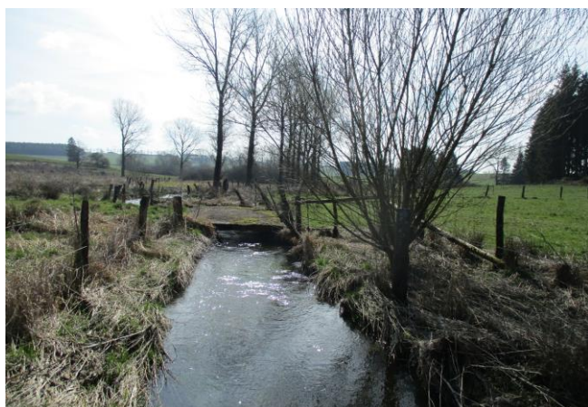
Foto gegen Fließrichtung
