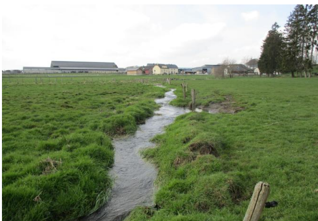
Foto gegen Fließrichtung
