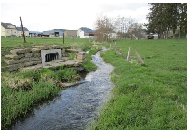
Foto gegen Fließrichtung
