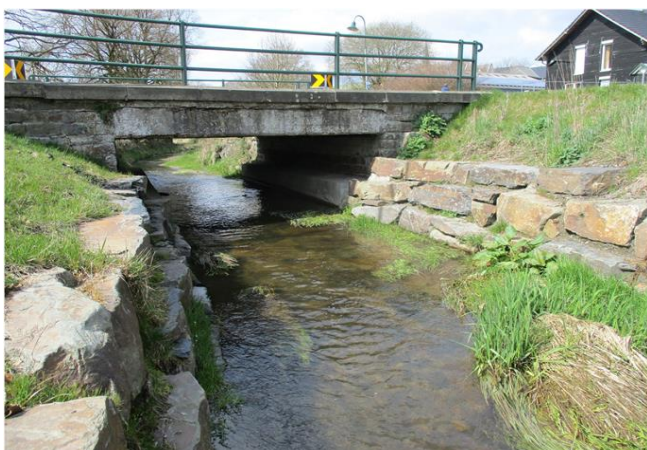
Foto gegen Fließrichtung
