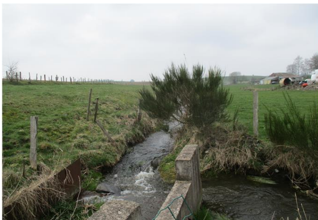
Foto gegen Fließrichtung
