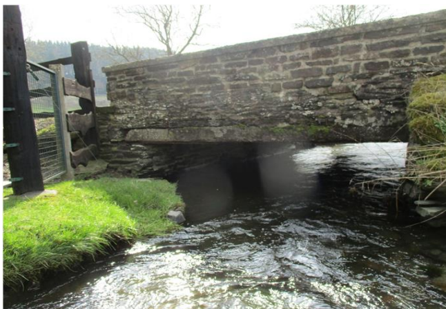
Foto gegen Fließrichtung
