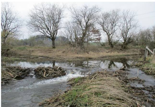
Foto gegen Fließrichtung
