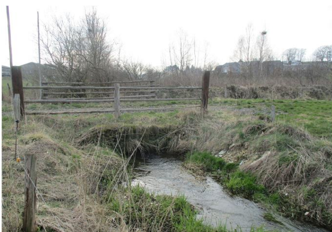
Foto gegen Fließrichtung
