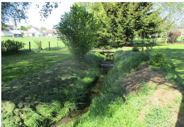
Foto gegen Fließrichtung
