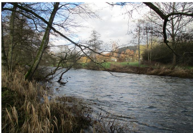
Foto gegen Fließrichtung
