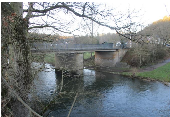
Foto gegen Fließrichtung
