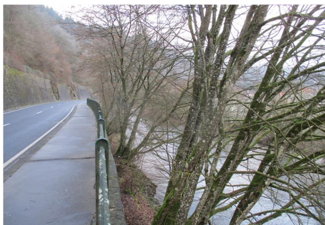
Foto gegen Fließrichtung
