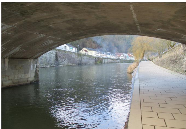
Foto gegen Fließrichtung
