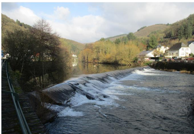
Foto gegen Fließrichtung
