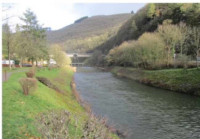
Foto gegen Fließrichtung
