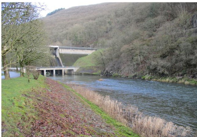
Foto gegen Fließrichtung
