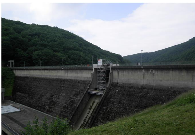
Foto gegen Fließrichtung
