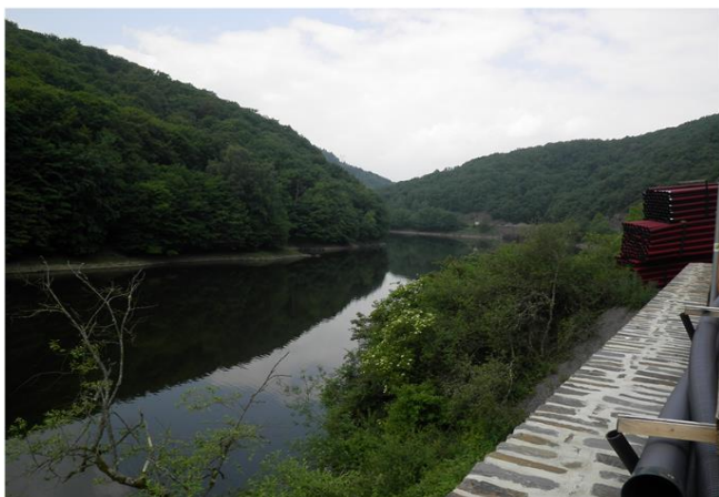
Foto gegen Fließrichtung
