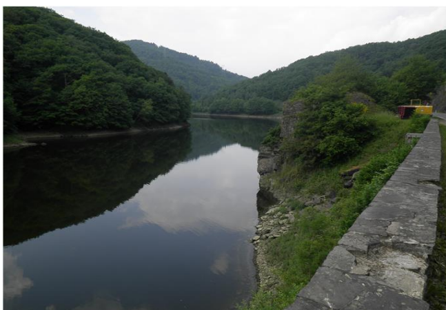
Foto gegen Fließrichtung
