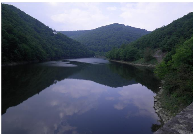
Foto gegen Fließrichtung
