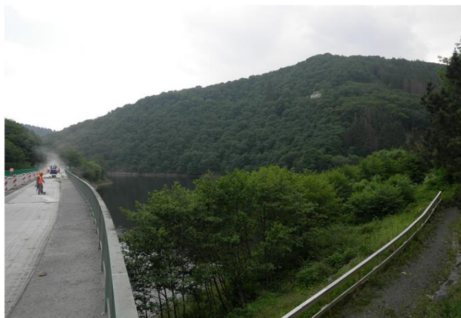
Foto gegen Fließrichtung
