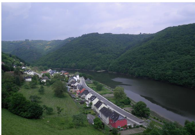
Foto gegen Fließrichtung
