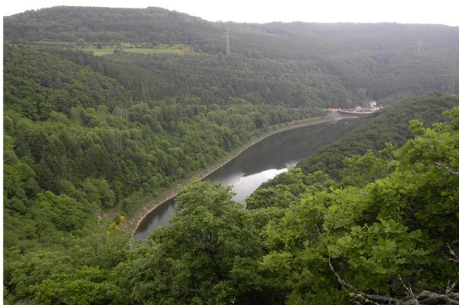
Foto gegen Fließrichtung
