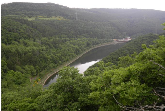
Foto gegen Fließrichtung
