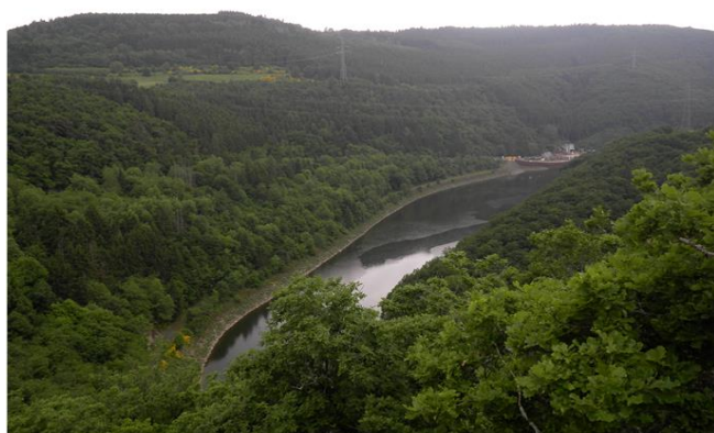
Foto gegen Fließrichtung
