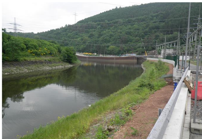
Foto gegen Fließrichtung
