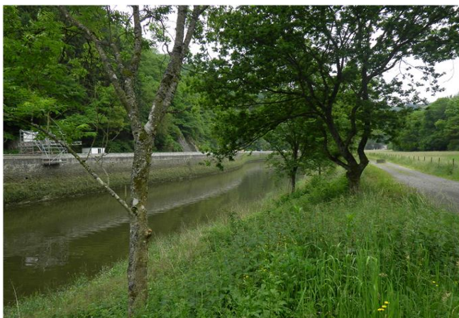
Foto gegen Fließrichtung
