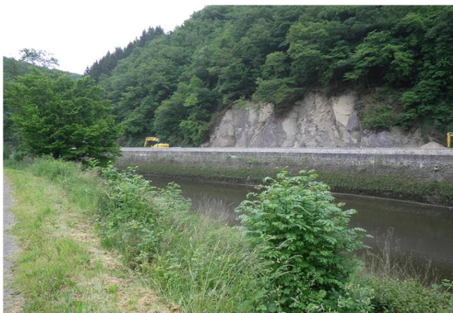
Foto gegen Fließrichtung
