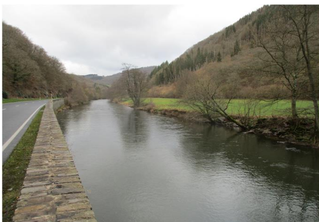
Foto gegen Fließrichtung
