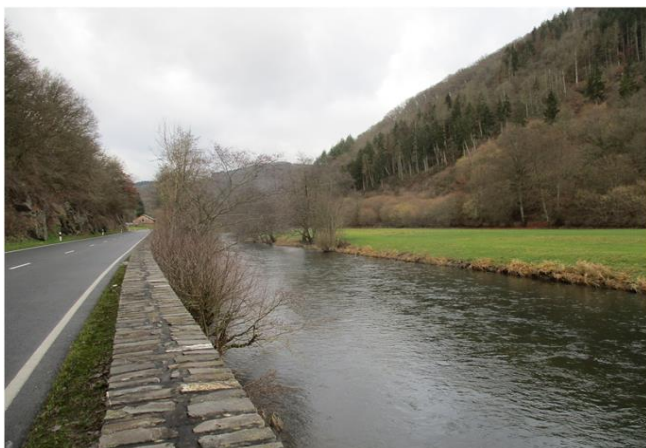
Foto gegen Fließrichtung
