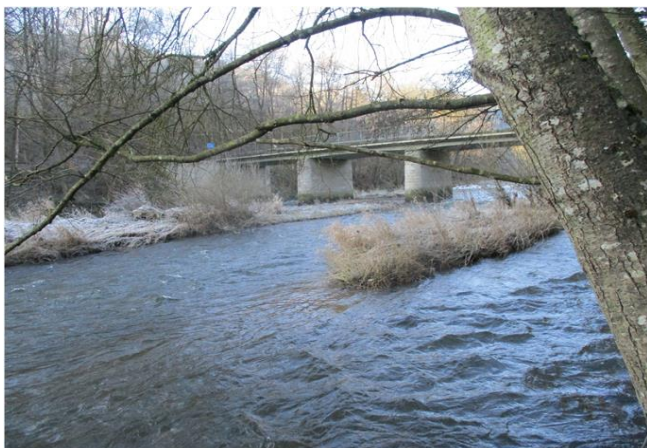
Foto gegen Fließrichtung
