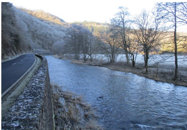
Foto gegen Fließrichtung
