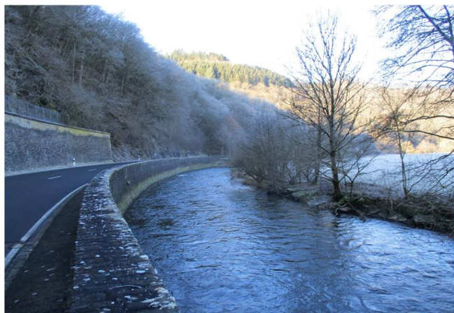
Foto gegen Fließrichtung
