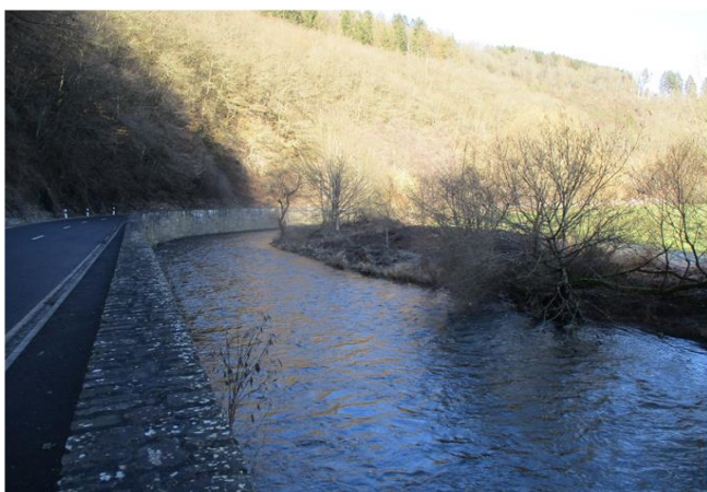
Foto gegen Fließrichtung
