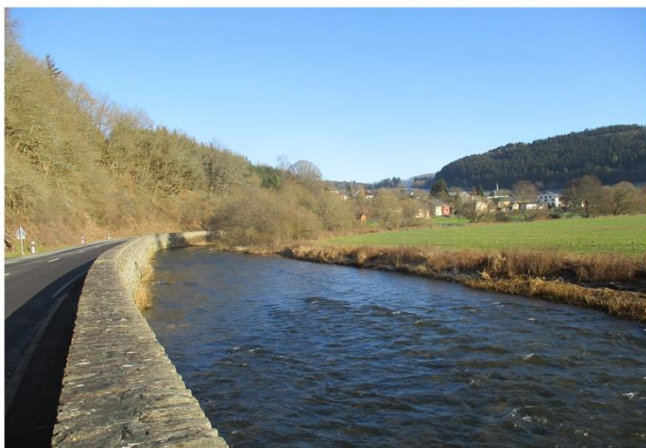
Foto gegen Fließrichtung
