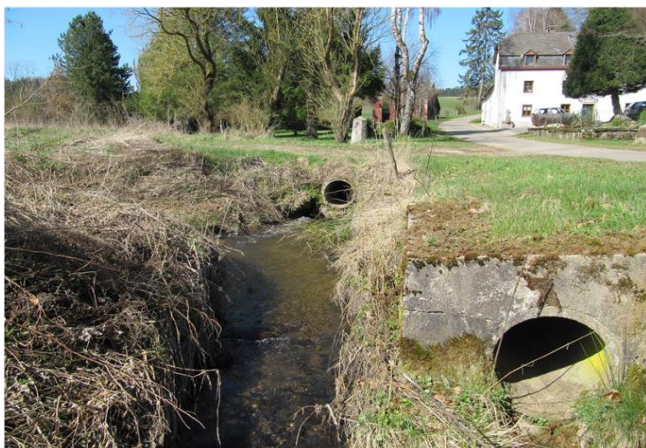
Foto gegen Fließrichtung
