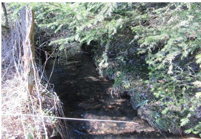
Foto gegen Fließrichtung
