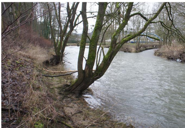
Foto gegen Fließrichtung
