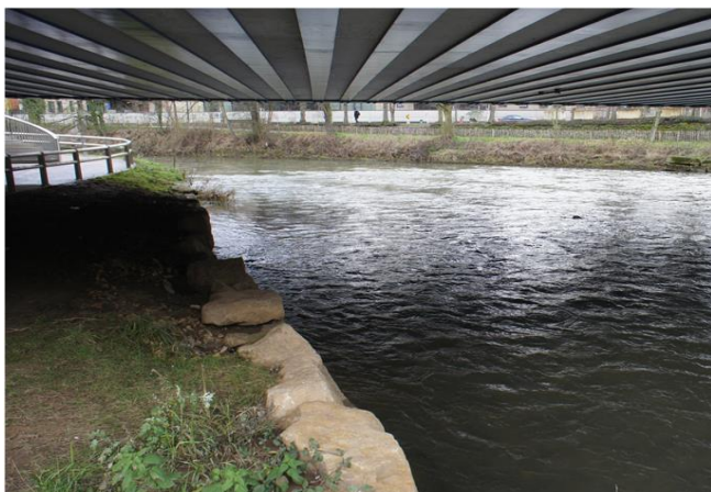
Foto gegen Fließrichtung
