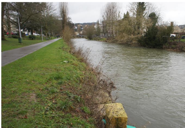
Foto gegen Fließrichtung
