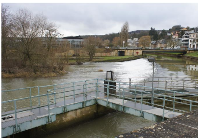
Foto gegen Fließrichtung
