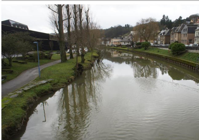
Foto gegen Fließrichtung
