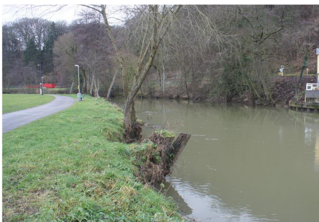
Foto gegen Fließrichtung
