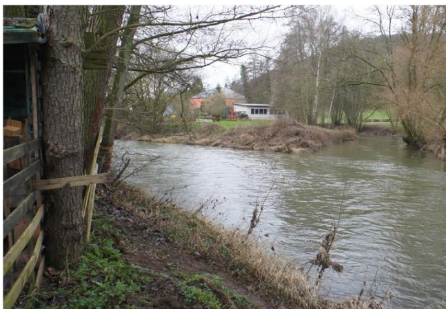
Foto gegen Fließrichtung
