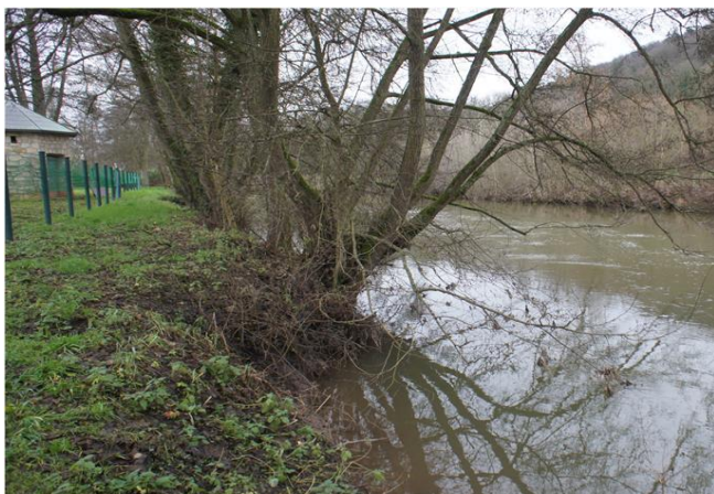
Foto gegen Fließrichtung
