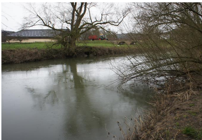
Foto gegen Fließrichtung
