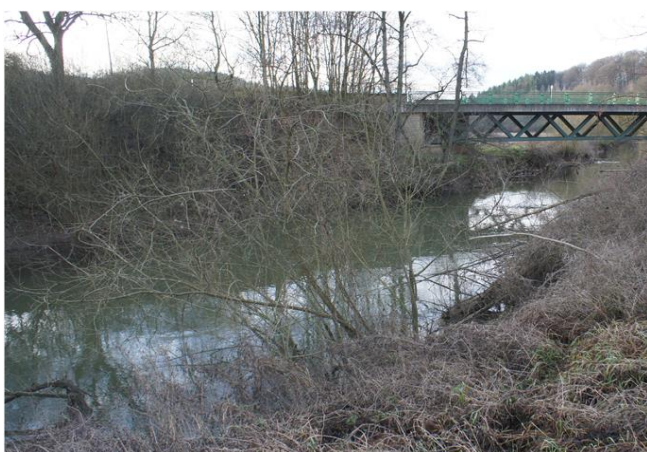
Foto gegen Fließrichtung
