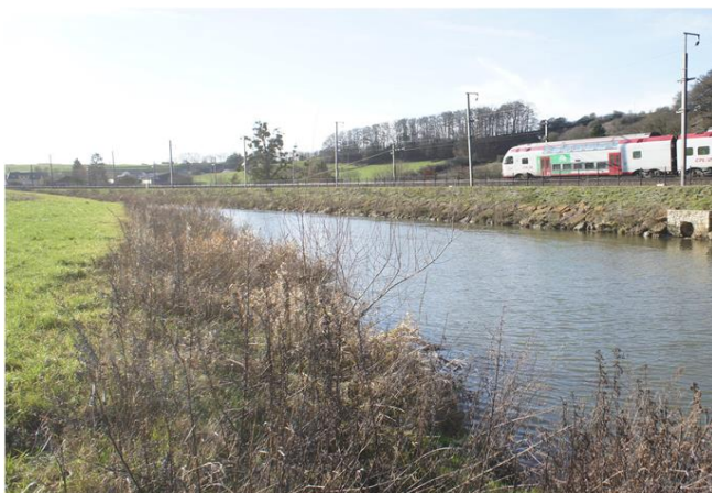
Foto gegen Fließrichtung
